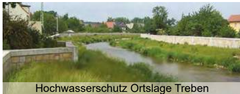
Hochwasserschutz Ortslage Treben
